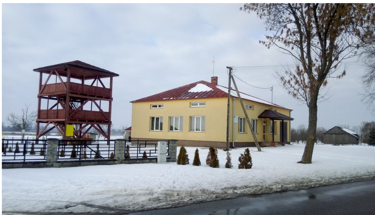
Zdjęcie 3: Wieża widokowa przy świetlicy wiejskiej w Żeliźnie (Fot. Urząd Gminy Komarówka Podlaska)
